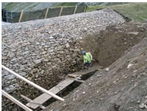
Abb. 130: Splügen, Galerie am Splügenpass. Die äussere Schale des Tunnelgewölbes während der Sanierung.
