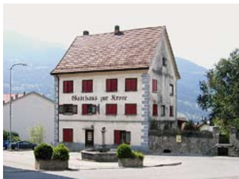
Abb. 172: Igis, Landquart, Gasthaus «Krone», Nr. 60. Blick gegen Norden.
