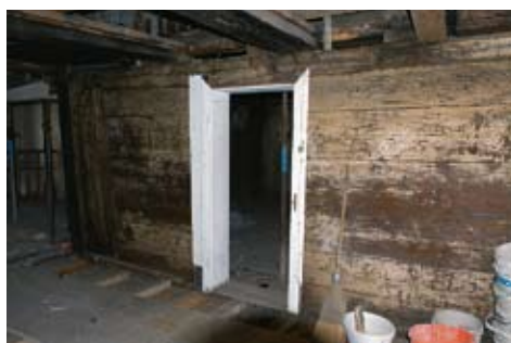
Abb. 68: Chur, Reichsgasse Nr. 57. Eine Zwischenwand des spätgotischen Bohlenbaus im 1. Obergeschoss. Blick gegen Südosten.
