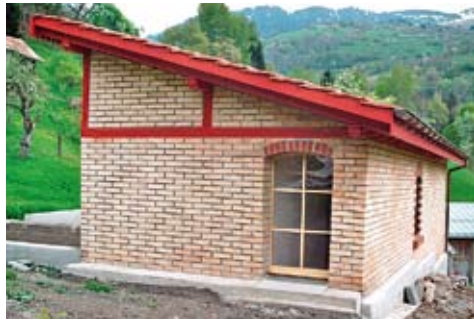
Abb. 157: Sevgein, Isla Fri, Hühner- und Entenstall, Nr. 55. Eingang von Südwesten.
