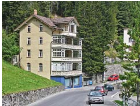
Abb. 170: Arosa, ehem. Pension «Villa Sonnenschein», Nr. 584. Blick gegen Osten.
