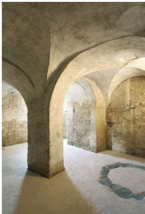
Abb. 103: Malans, Haus «von Moos», Nr. 135. Ehemaliger Torkel, heute zum Festsaal mit Fussbodenheizung ausgebaut.
