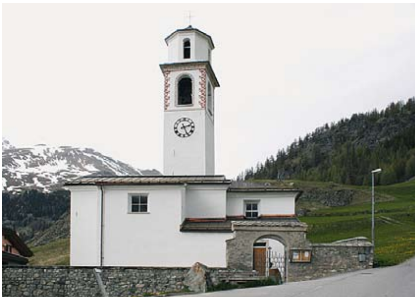
Abb. 163: Sur, Kirche S. Chatrina. Ansicht von Südosten.
