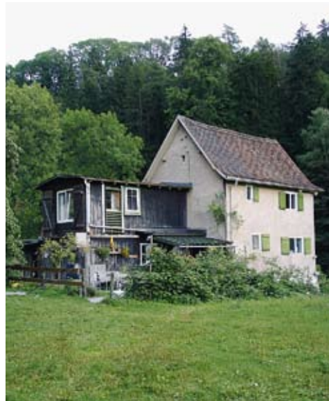
Abb. 1: Chur, Sandstrasse Nr. 19. Das Wohnhaus aus dem Jahre 1618 mit den späteren Holzanbauten vor dem Abbruch. Blick gegen Süden.
