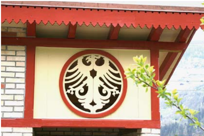
Abb. 158: Sevgein, Isla Fri, Hühner- und Entenstall, Nr. 55. Detail der schmückenden Adler in Laubsäge- technik.
