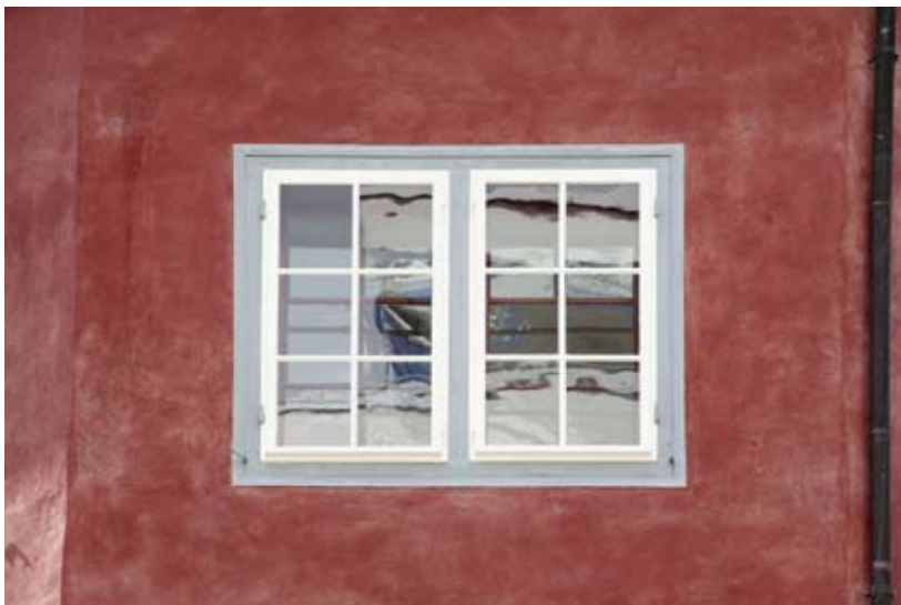
Abb. 118: Chur. Haus «Roter Turm», Nr. 188. Einfach verglastes Fenster mit Winterfenster.
