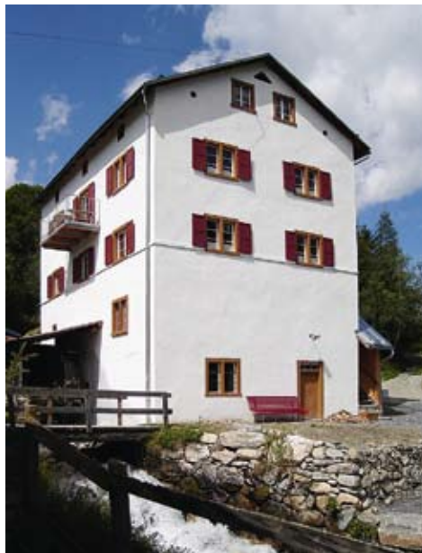
Abb. 153: Salouf, Mühle Vigl Muleg, Nr. 128. Ansicht der Süd- und Ostfassaden.
