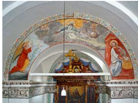
Abb. 164: Sur, Kirche S. Chatrina. Chorbogen mit den neu eingebauten, holzverkleideten Zugstangen.
