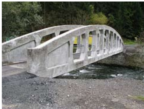
Abb. 148: Luzein, Dalvazza, alte Landquartbrücke Dalvazza. Die Brücke nach der Instandsetzung.
