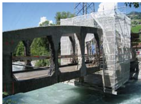
Abb. 147: Luzein, Dalvazza, alte Landquartbrücke Dalvazza. Das fahrbare Baugerüst für die Instandsetzungsarbeiten.
