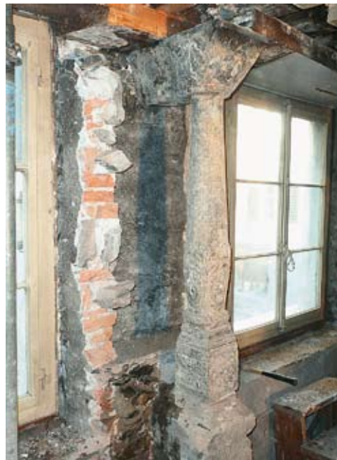
Abb. 69: Chur, Reichsgasse Nr. 57. Freigelegte Fenstersäule in der südlichen Stube des 1. Obergeschosses. Blick gegen Nordwesten.
