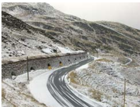
Abb. 131: Splügen, Galerie am Splügenpass. Die Baustelle nach dem überraschend frühen Wintereinbruch.
