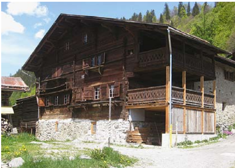
Abb. 149: Luzein, Putz, Haus Nr. 231. Südfassade und ostseitiger Laubenanbau.
