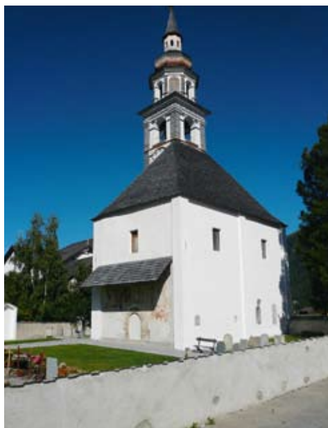
Abb. 53: Bever, evangelisch-reformierte Kirche. Kirche und Turm nach der Renovation des Jahres 2007. Blick gegen Nordosten.
